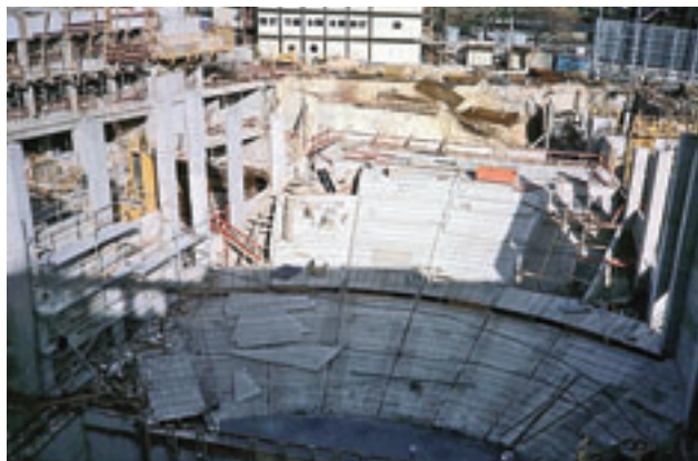
Grand Écran en construction.
